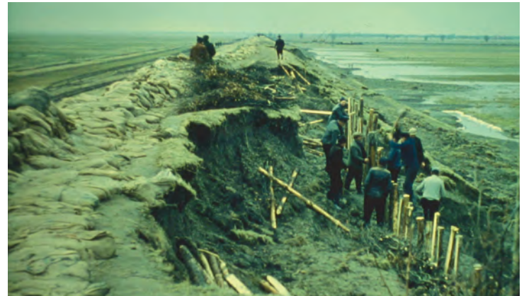
Abb. 6: Reparaturarbeiten nach der Sturmflut von 1962, Quelle: Hans Kunz.
