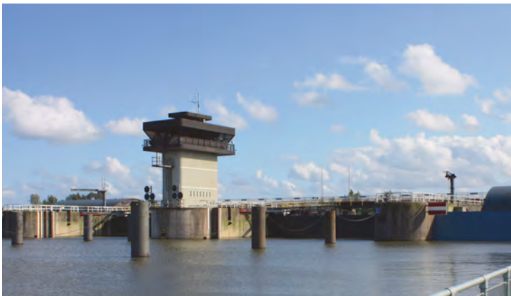
Abb. 21: Hunte-Sperrwerk in Elsfleth, Foto: Frank Ahlhorn.
