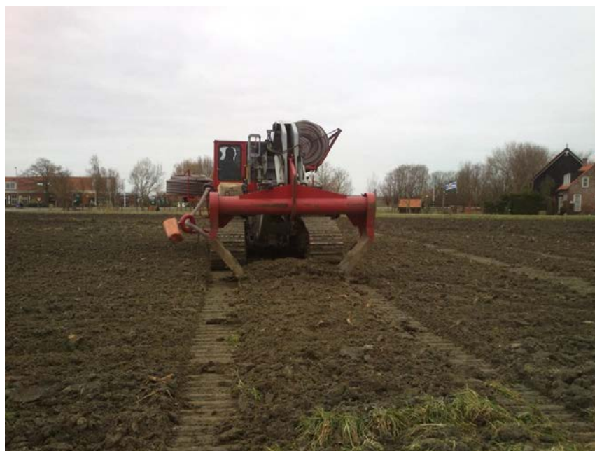
Figuur 2.6 Aanleg van de peilgestuurde drainage.
