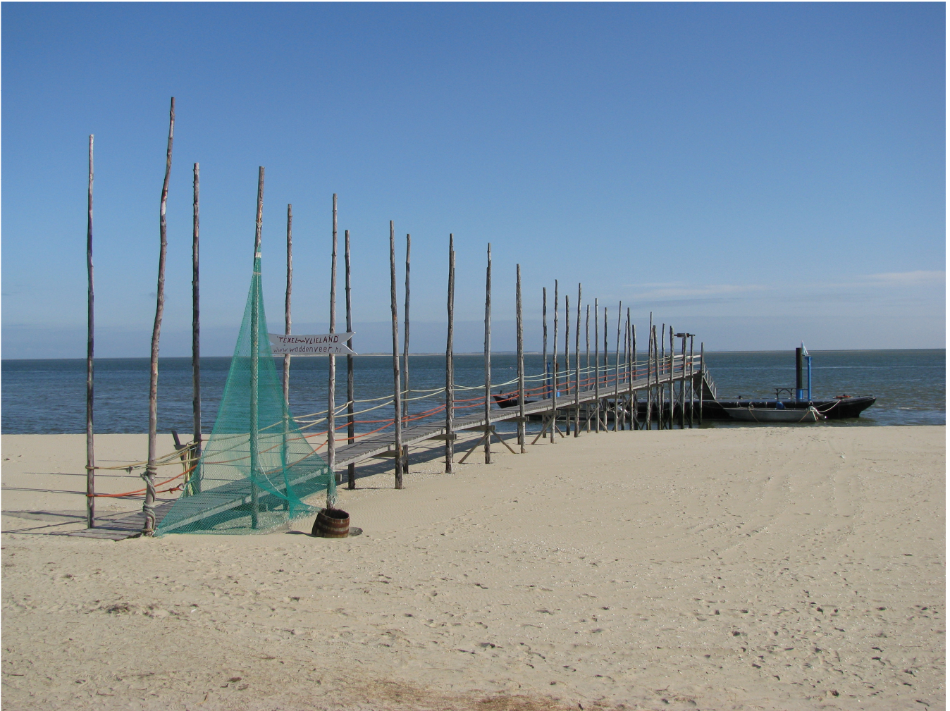
Afbeelding 15: Steiger met flexibele loopplank en ponton in Texel (Texel Elements)
